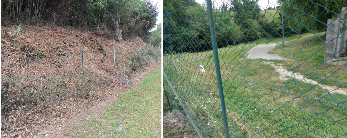
Figure 24 : Grillage de la station vétuste
